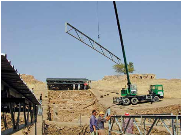
Abb. 14: Aufbau der älteren Schutzdächer im Hauptgrabungsgebiet (DAI, Foto K. Schmidt).
