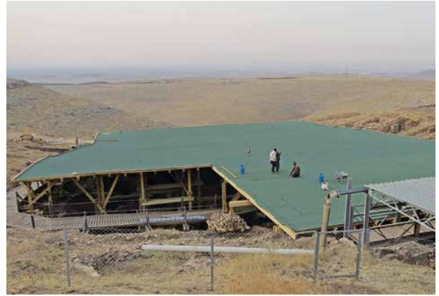
Abb. 16: Das temporäre Schutzdach über dem Hauptgrabungsgebiet (DAI, Foto K. Schmidt).
